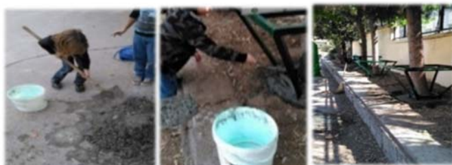
Εικόνες 23, 24, & 25: Συμμετοχή στην τοποθέτηση σιδηροκατασκευών
