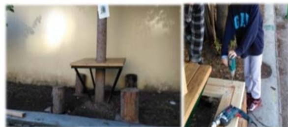
Εικ. 29 & 30: Τοποθέτηση κορμών-καθισμάτων όλων (Εικ. 29,& 30)
