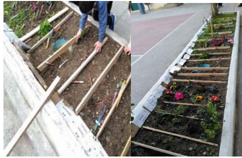
Εικόνες 8, 9. Διαμόρφωση και τοποθέτηση ξύλινων διαχωριστικών
